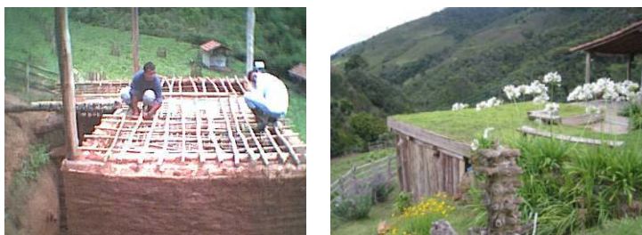
Figs. 3 e 4. Montagem de teto verde no bairro Jequiri em Itamonte-MG . A esquerda imagem do início de construção em 06/2001, e a da direita imagem atual 02/2008.
