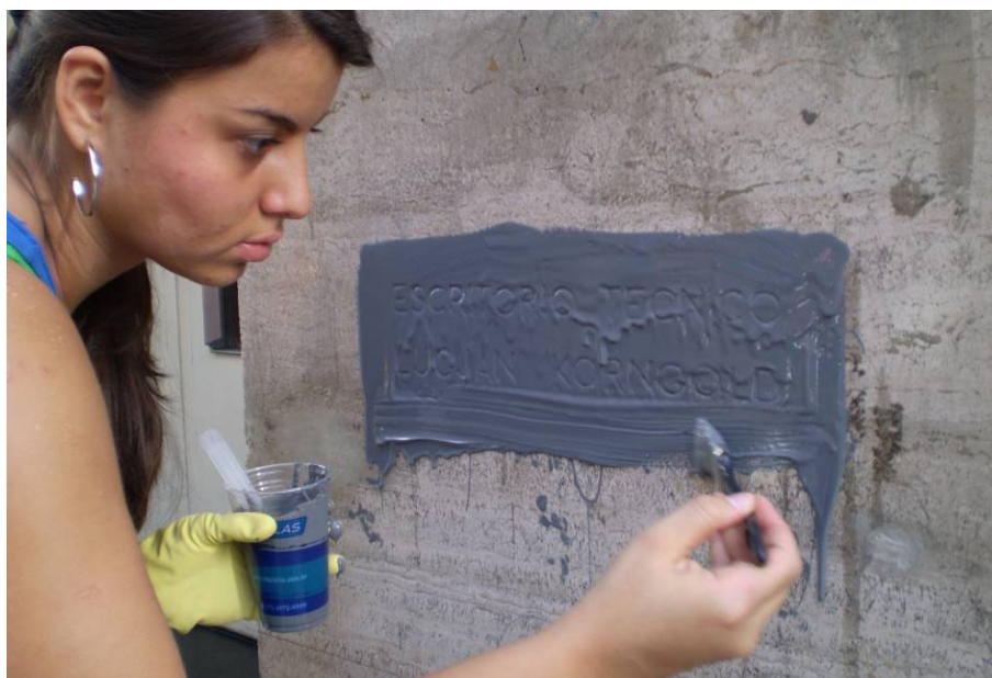
Fig.5 A bolsista aplica uma camada de silicone na epígrafe. (Foto: Flávio Cescato)
