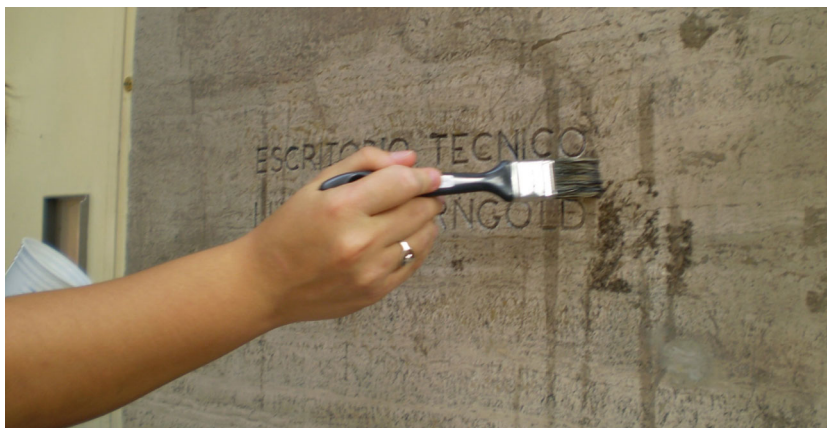
Fig.3. A bolsista Fernanda Indicatti aplica desmoldante na epígrafe. (Foto: Flávio Cescato)
