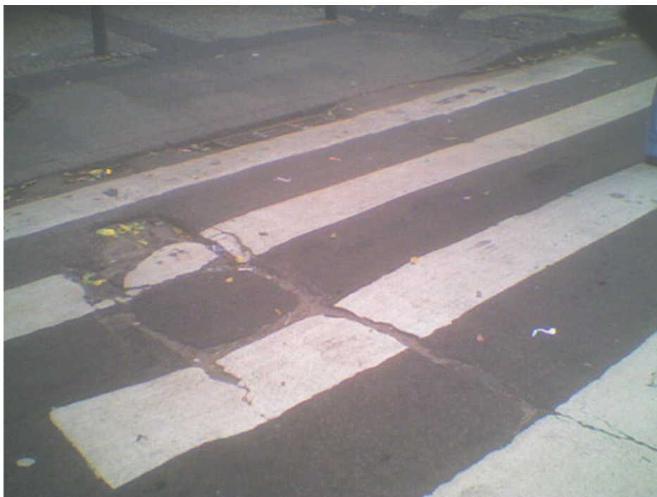
Figura 5: Acidentários – Caminhos mal conservados em algumas travessias. Pode ocasionar acidentes sérios, principalmente entre pedestres idosos.
